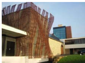
2009 : Réhabilitation Centre civique et culturel de Montours Coglais Communauté
