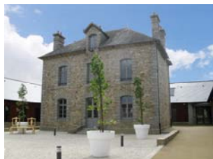
2011 : Réhabilitation de l'ancienne école de Saint- Aubin du Cormier en Espace Loisirs de Culture
